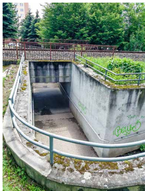
Podchod pod tratí vznikl v době výstavby sídliště Družba (dnes Jih) ve druhé polovině 70. let.
