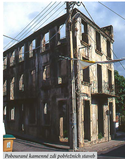
Pobourané kamenné zdi pobřežních staveb
